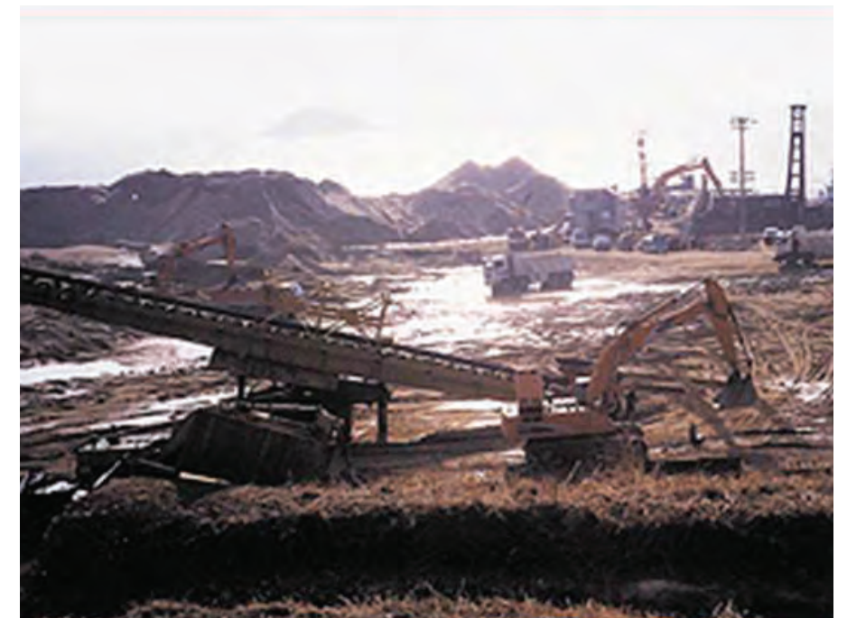
▲ 1990년 동아매립지(현 청라지구) 조성공사
