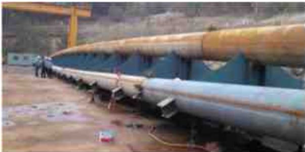
⑤ Main Pipe girder 가조립
