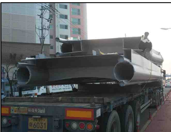
③ 강관거더 공장제작 후 현장운반
