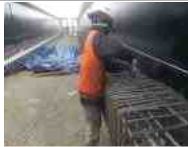
④ 철근 및 쉬스관 설치
