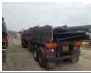
② I-Girder 현장 반입
