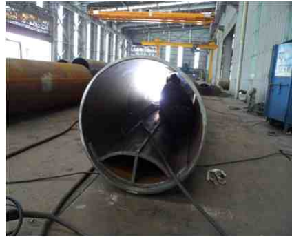
② 강관조립 및 용접
