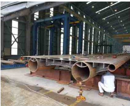
③ 주거더, Deck 및 Side 강관 가조립
