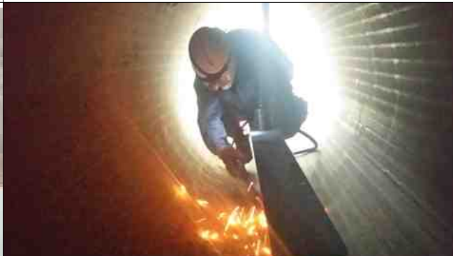
④ 조립 및 용접
