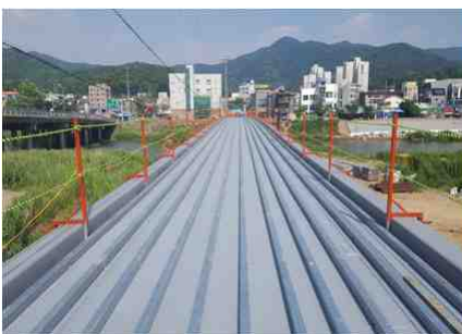
⑦ 상부 각관 및 DECK설치
