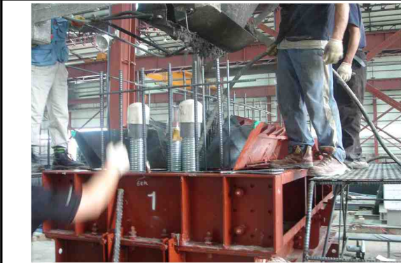
STEP 3 : 콘크리트 타설 및 양생
