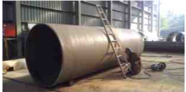
④ Main Pipe 조립, 용접
