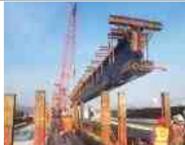
⑤ 콘크리트타설대 이동
