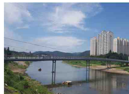
⑧ 공사 완료
