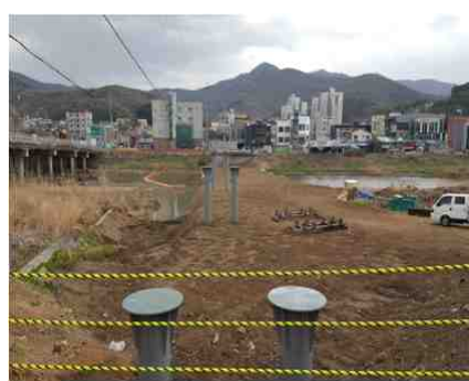
④ 강관파일 천공, 항타 및 CAP설치
