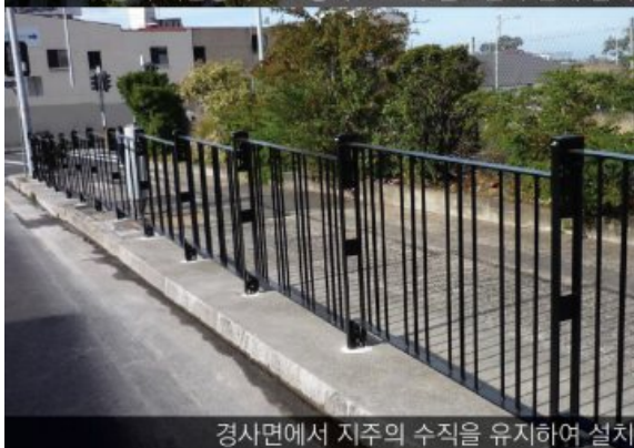
차량의 이탈방지와 보행자 보호가 필요한 구간에 설치
