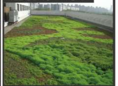
세덤을 통한 옥상녹화 조성 예시
